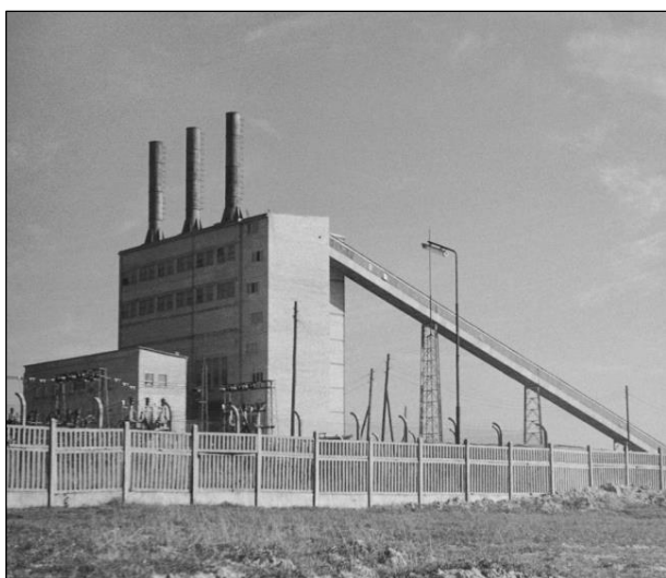
Fot 7. Elektrociepłownia na terenach przemysłowych otwarta w 1960 roku Źródło: [ http://www.abc.tychy.pl/fotografia/859 ] Photo 7. Thermal power plant in the industrial areas opened in 1960 Source: [ http://www.abc.tychy.pl/fotografia/859 ]
