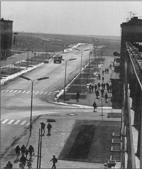
Fot. 1. Ul. Dzierżyńskiego zakończona wykopem kolejowym, po drugiej stronie pola uprawne, rok 1969
