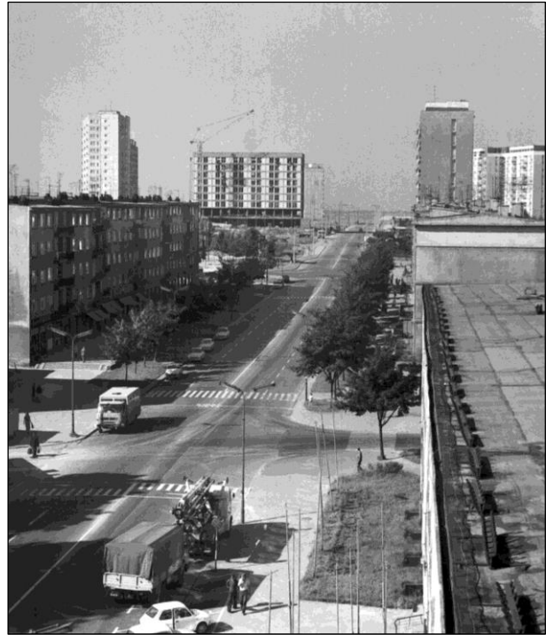
Fot. 2. Ul. Dzierżyńskiego, w oddali osiedla M i N oraz Hotel Tychy, rok 1975
